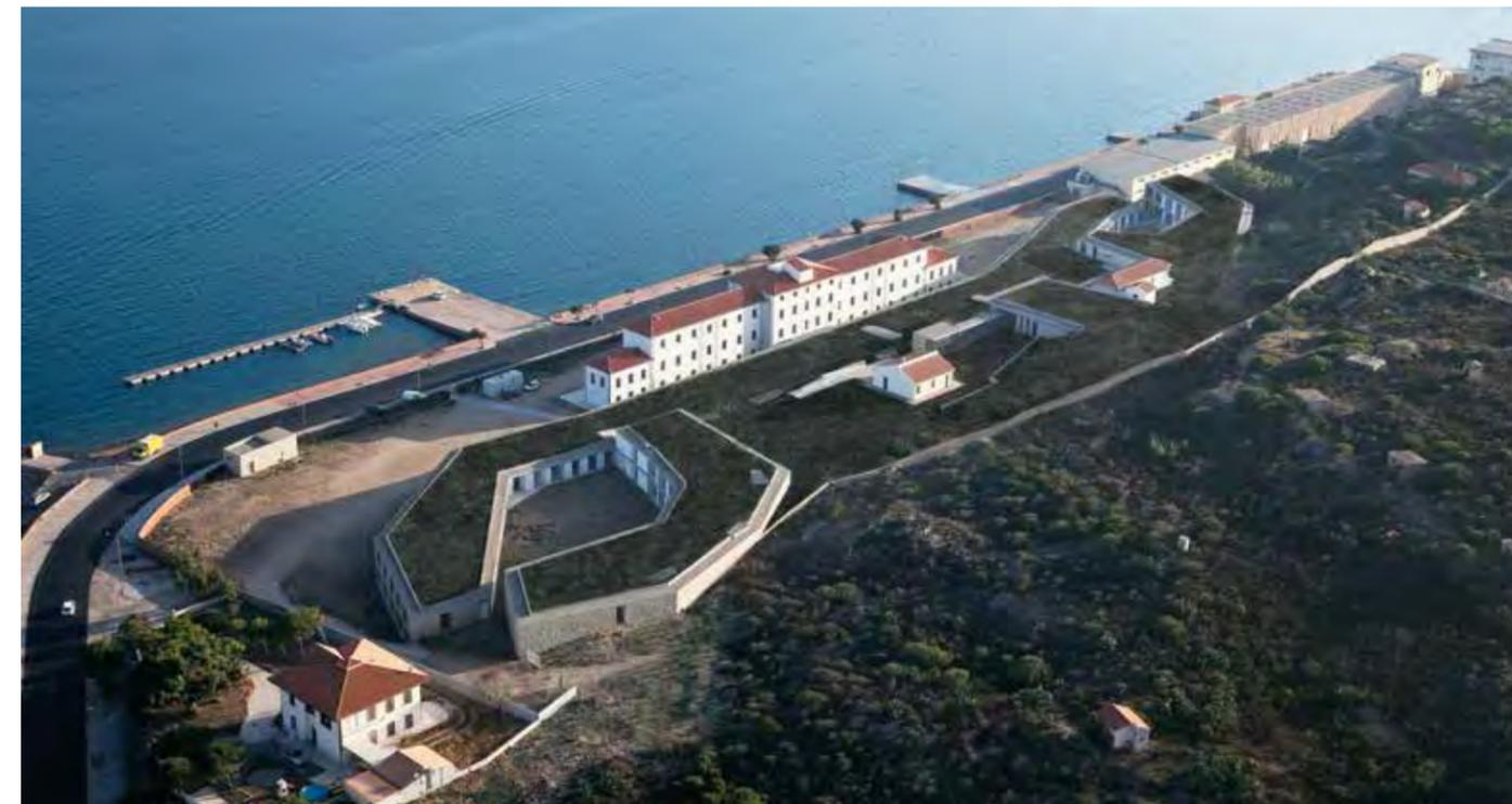
Per evidenziare l'effetto di edificio concepito come semplice linea di discontinuità della costa, come muro di contenimento e, al contempo, differenziarsi dal corpo originario dell'Ex Ospedale, il fronte del nuovo profilo è stato rivestito con blocchi di granito locale. Il nuovo albergo, che si sviluppa su una superficie complessiva di circa 13900 metri quadrati, riproduce sulla copertura, piantumata a verde, la superficie naturale occupata dall'edificio non consumando suolo.
