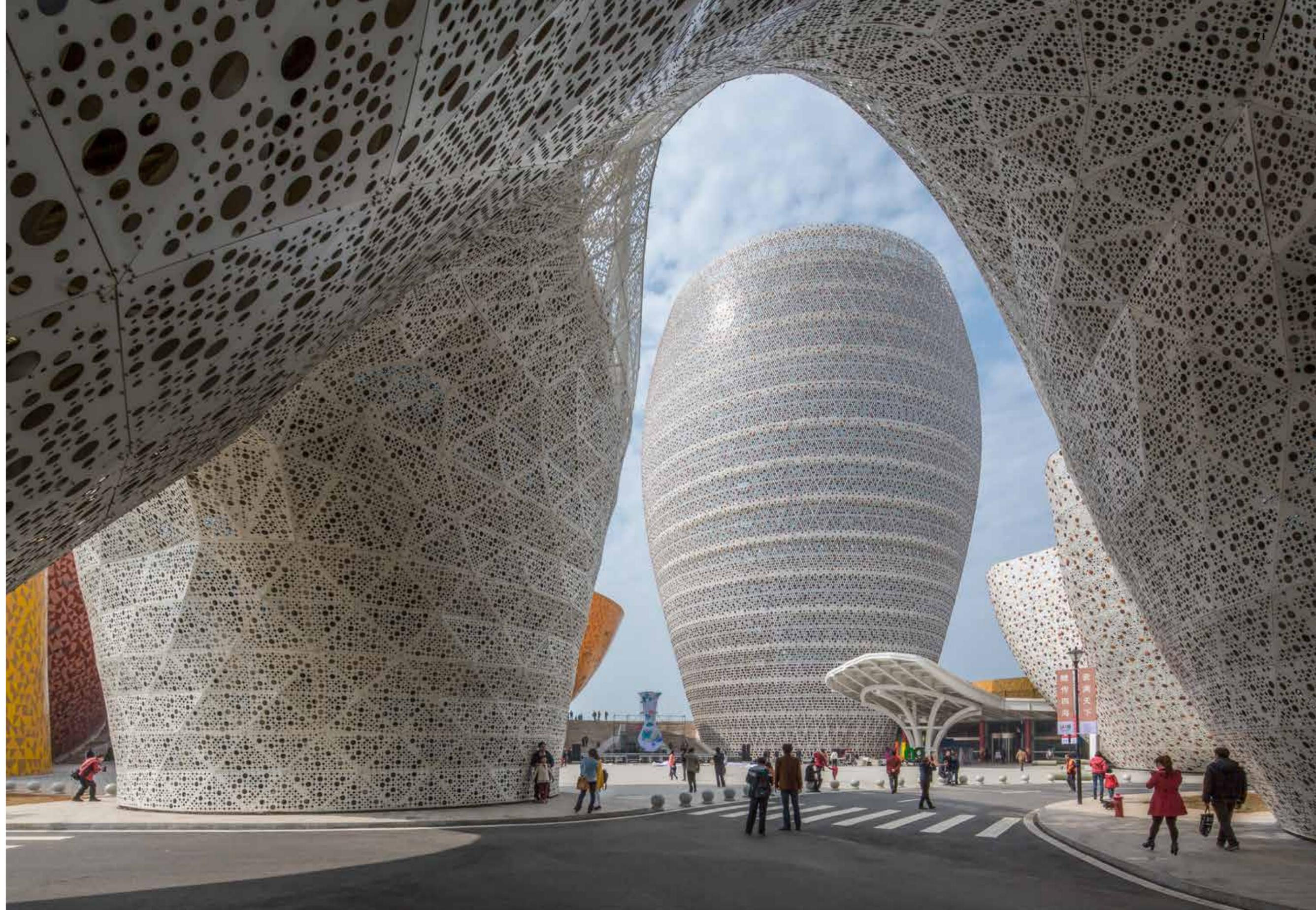
Di fondamentale importanza è la modellazione degli edifici in forma di grandi “vasi” con contorni sinuosi senza spigoli vivi, sempre concavi o convessi, rivestiti da moduli ceramici policromi componenti originali texture tridimensionali. In linea con il sistema proposto dal progetto, la densità diventa un valore, una risorsa che consente un rapporto stretto, una vicinanza, un uso del territorio simile a quello che caratterizza la città storica della tradizione cinese.
